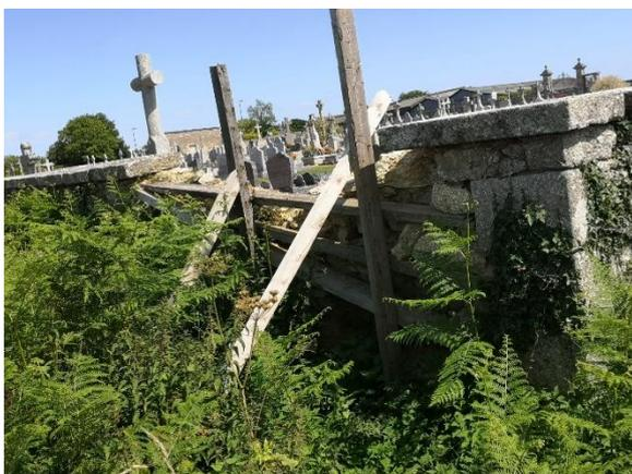
Un véhicule a détruit l'angle sur le bord de la route de Broons. Ce mur n'a pas été réalisé à l'origine avec du ciment, et sera donc refait à l'identique. C'est l'association Steredenn de Dinan (qui organise des chantiers de formation et de réinsertion) qui a été choisie pour reconstruire ces 2 morceaux de murs.
